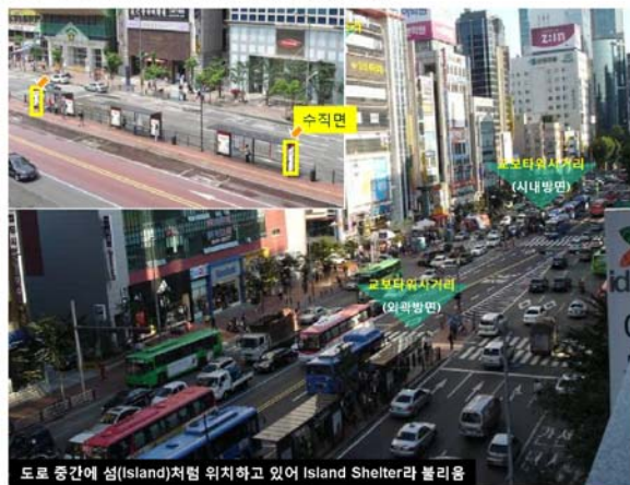
교보타워 사거리 전경사진 (Island Shelter)
